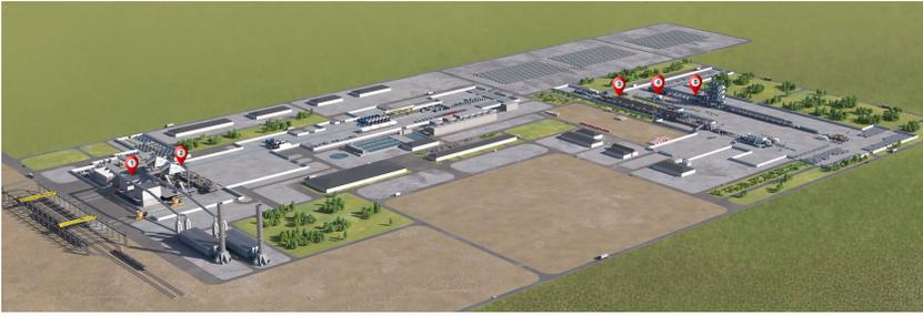
SDI bestellt bei der SMS group für den neuen Standort in Sinton eine komplette Stahlproduktionslinie zur Herstellung von Spezialgütern. 1) Zwei Gleichstrom-Elektrolichtbogenöfen, zwei Doppel-Pfannenöfen und eine Doppel-Vakuum-Tankentgasungsanlage 2) CSP®-Anlage der neusten Generation 3) Fünfgerüstige Beiz-/Tandemstraße 4) Dressierwalzwerk 5) Verzinkungslinie
